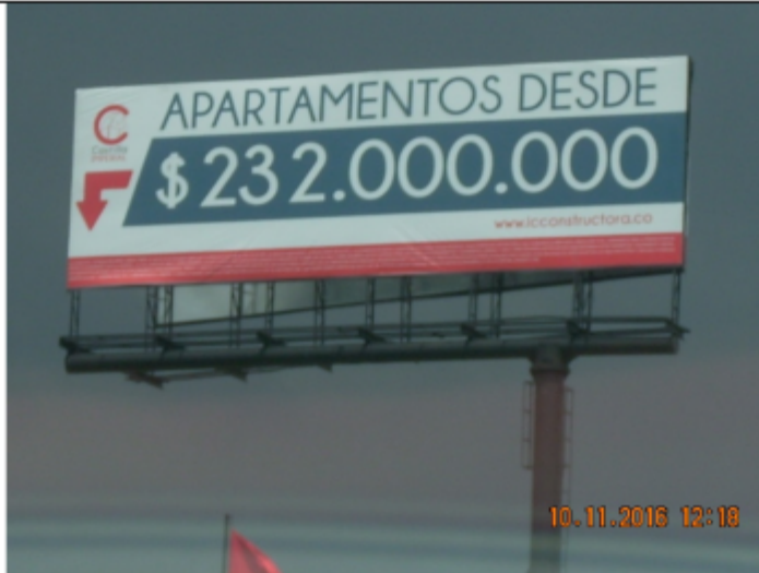
FOTOGRAFIA 2: Vista de tablero de la valla tubular instalada en el inmueble Carrera 86 No. 7D - 35 sentido Norte - Sur.
